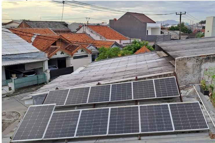
Gambar 2. Modul Panel Surya Dengan Konfigurasi 3S4P
